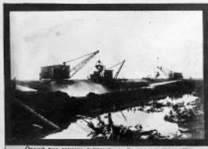
Общий вид плотины, наблюдающие по новому стандарту.
