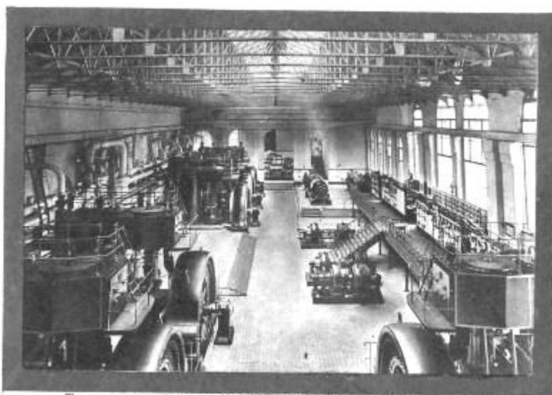
Внутренний вид Московской станции имени Смидовича с первоначальным оборудованием.
