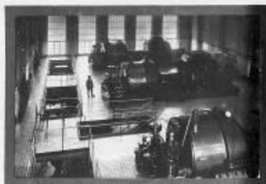
Внутренний вид ГЭС «Электropредача».
