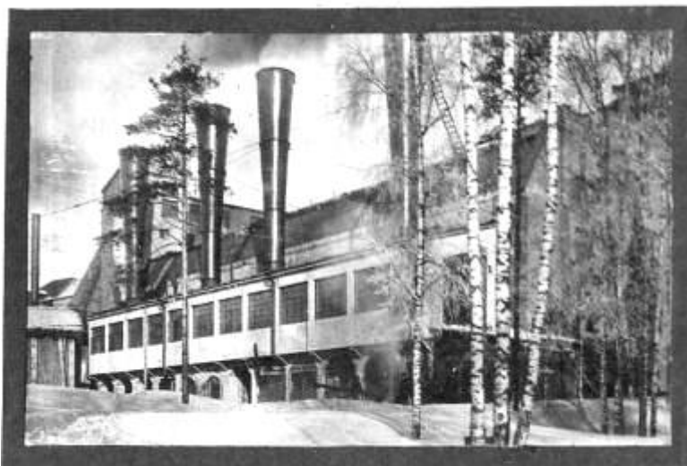
Новая котельная ГЭС „Электропередача“.
