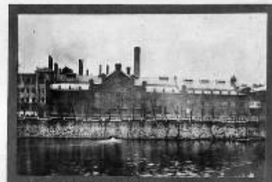
Вид Московской станции им. Сидорвича после ее перестройки в 1910-11 гг.
