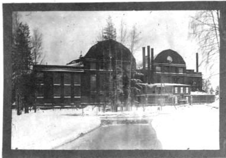
Общий вид ГЭС „Электропередача“ до переустройства.
