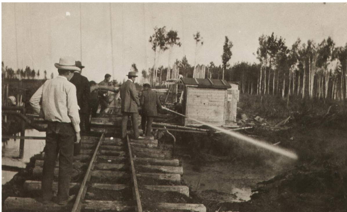
Опыт размыва торфа струей воды, август 1915 г. (ориг. фото – ф. 9508 РГАЭ) {(на переднем плане – И.Р. Классон, на заднем – Р.Э. Классон)}
