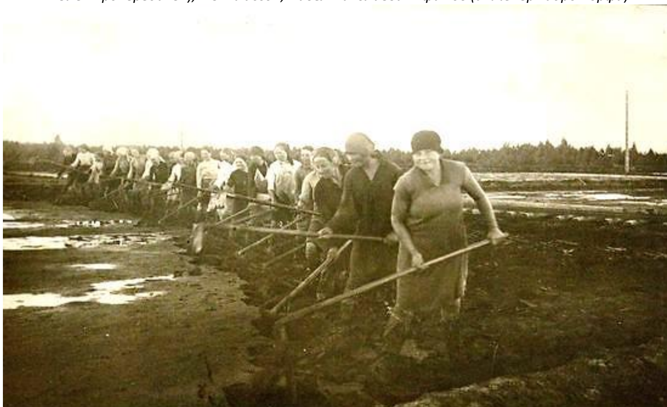
Ручная цапковка гидроторфа (с сайта Музея Мосэнерго)
