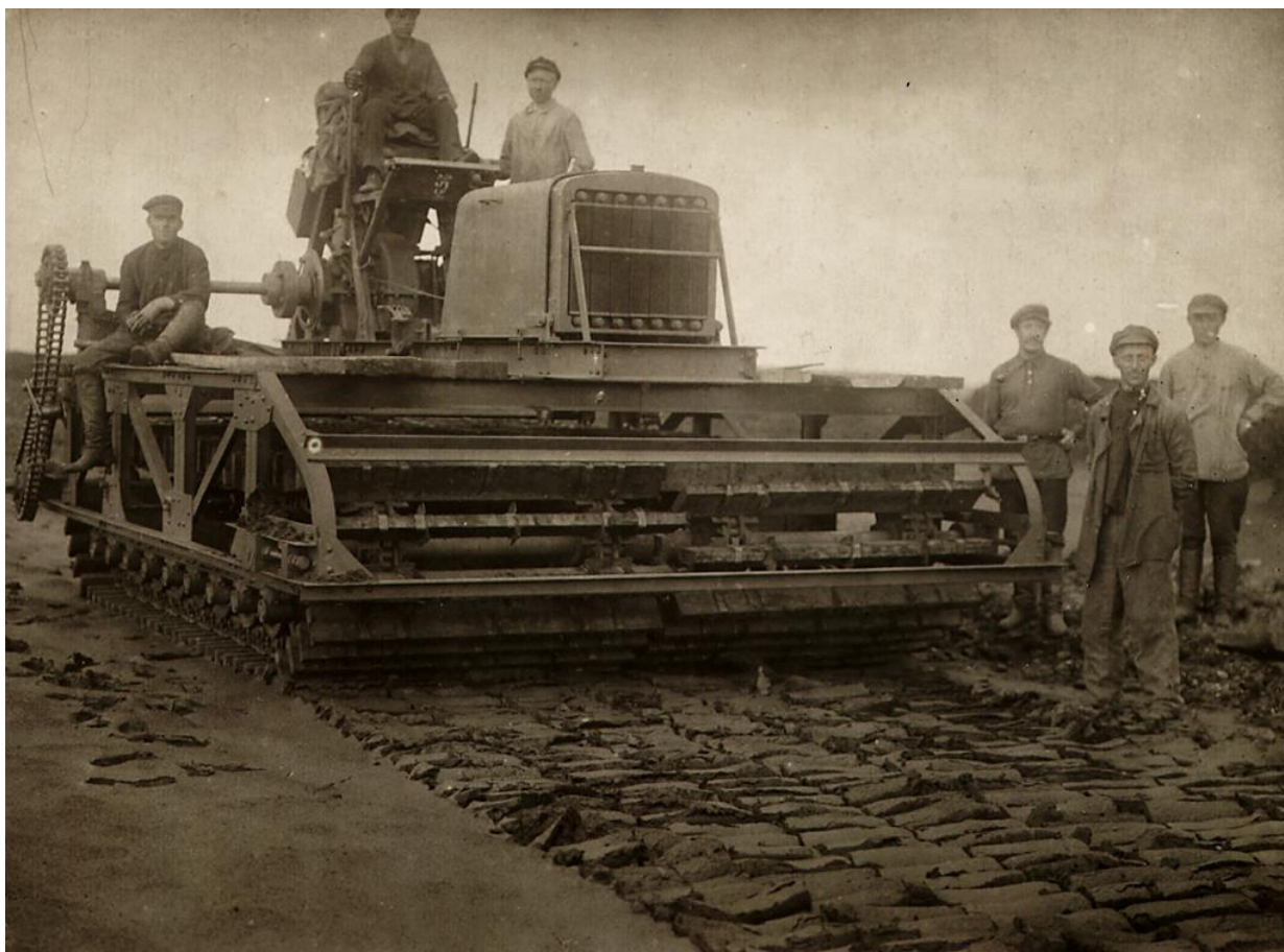
Формующие гусеницы на собственном ходу (сконструированы К.Е. Мягковым уже после смерти Р.Э. Классона)
