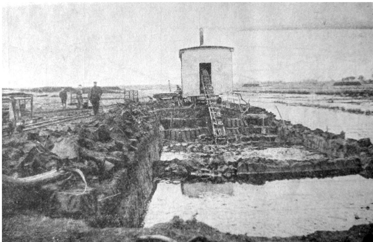
*При добыче торфа на глубине 1,5 метров уже может выступить вода (фото из книги «Гидроторф», 1923 г.)*
